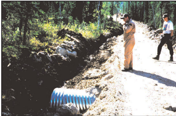
Évaluation environnementale du site.
