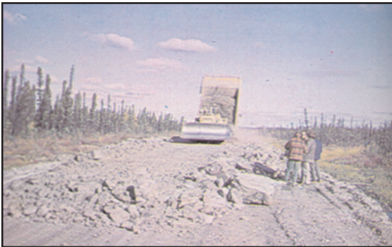
Construction d'une route d'accès.
