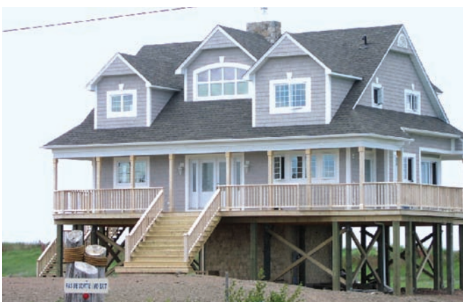
FIGURE 18 : La construction de bâtiments sur pilotis est un exemple d'adaptation réduisant la vulnérabilité aux ondes de tempête. Grand-Barachois (près de Shediac), détroit de Northumberland, sud-est du Nouveau-Brunswick. Photo gracieuseté d'Armand Robichaud.
