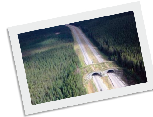
Structure de passage de la faune sur la Transcanadienne dans le parc national Banff ©Parcs Canada
