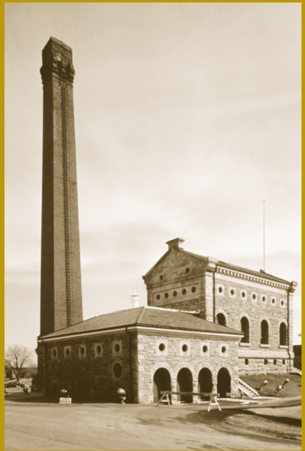
Construit de 1857 à 1859, l'aqueduc de Hamilton est le seul système datant du milieu du XIX e siècle encore intact en Amérique du Nord. Les machines de la pompe à vapeur à faisceau composite qui définissent la valeur patrimoniale du lieu ont été remises en état en 1998.
