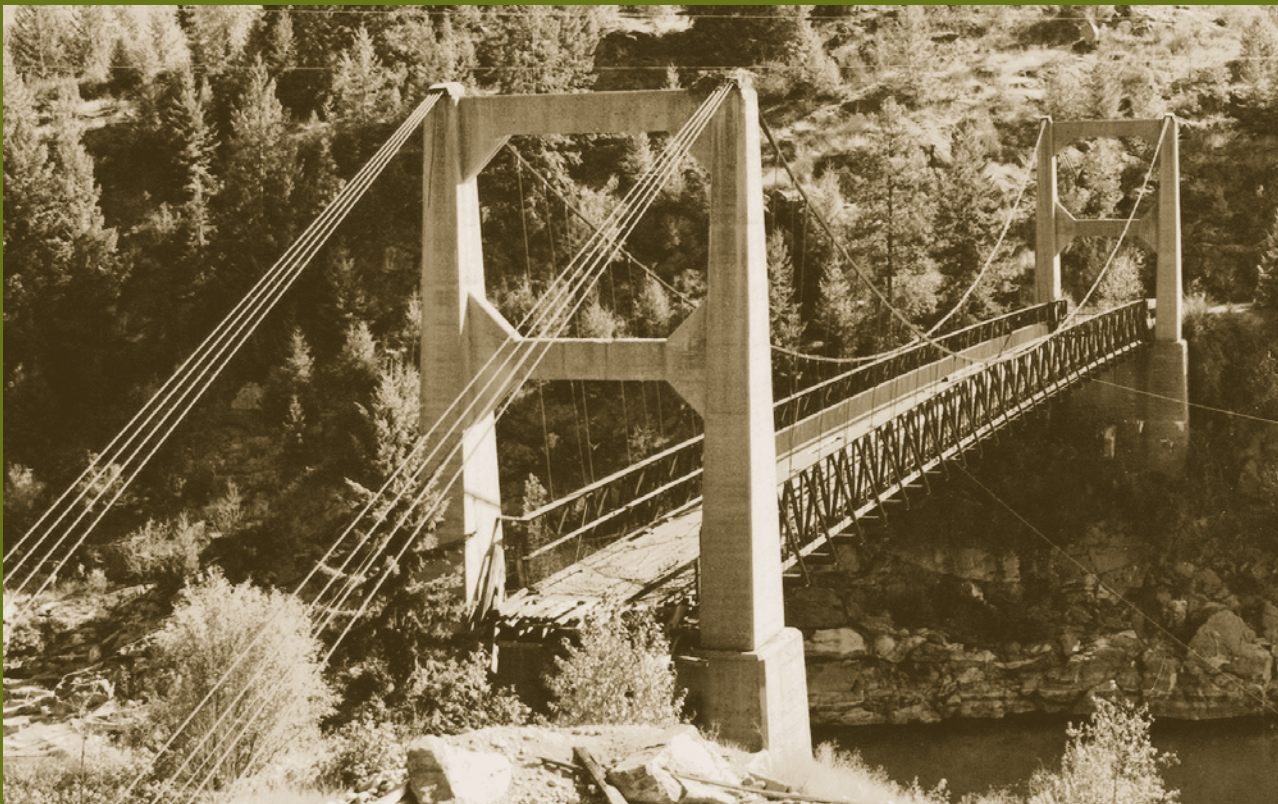
Le pont suspendu de Brilliant a été construit en 1913 sur la rivière Kootenay, près de Castlegar, en Colombie-Britannique. Assurer la sécurité du public est l'un des premiers soucis des ingénieurs.
