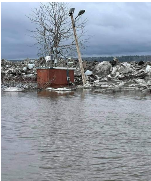
Station hydrométrique du fleuve Mackenzie à Fort Simpson (10GC001) pendant la débâcle de 2021 – la station hydrométrique a ensuite été détruite par la glace.
