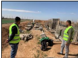
Image 6 : deux travailleurs sur un chantier.
