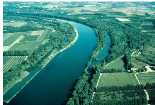
Rhône court-circuité de Donzère-Mondragon. Endiguements Girardon du 19 ème siècle, milieux annexes et forêt alluviale résiduelle. Photo : Frapna 26.
