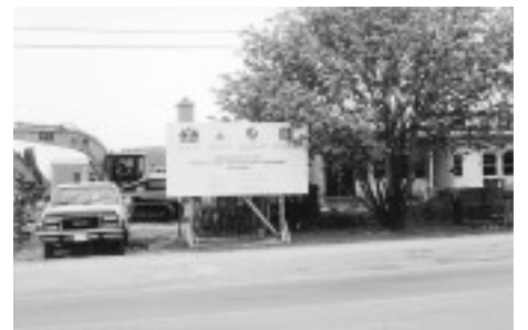
Construction du Centre scolaire et communautaire de London.
