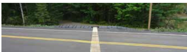
Tunnel de la route 117 à Kouchibouguac Photo : © Agence Parcs Canada
